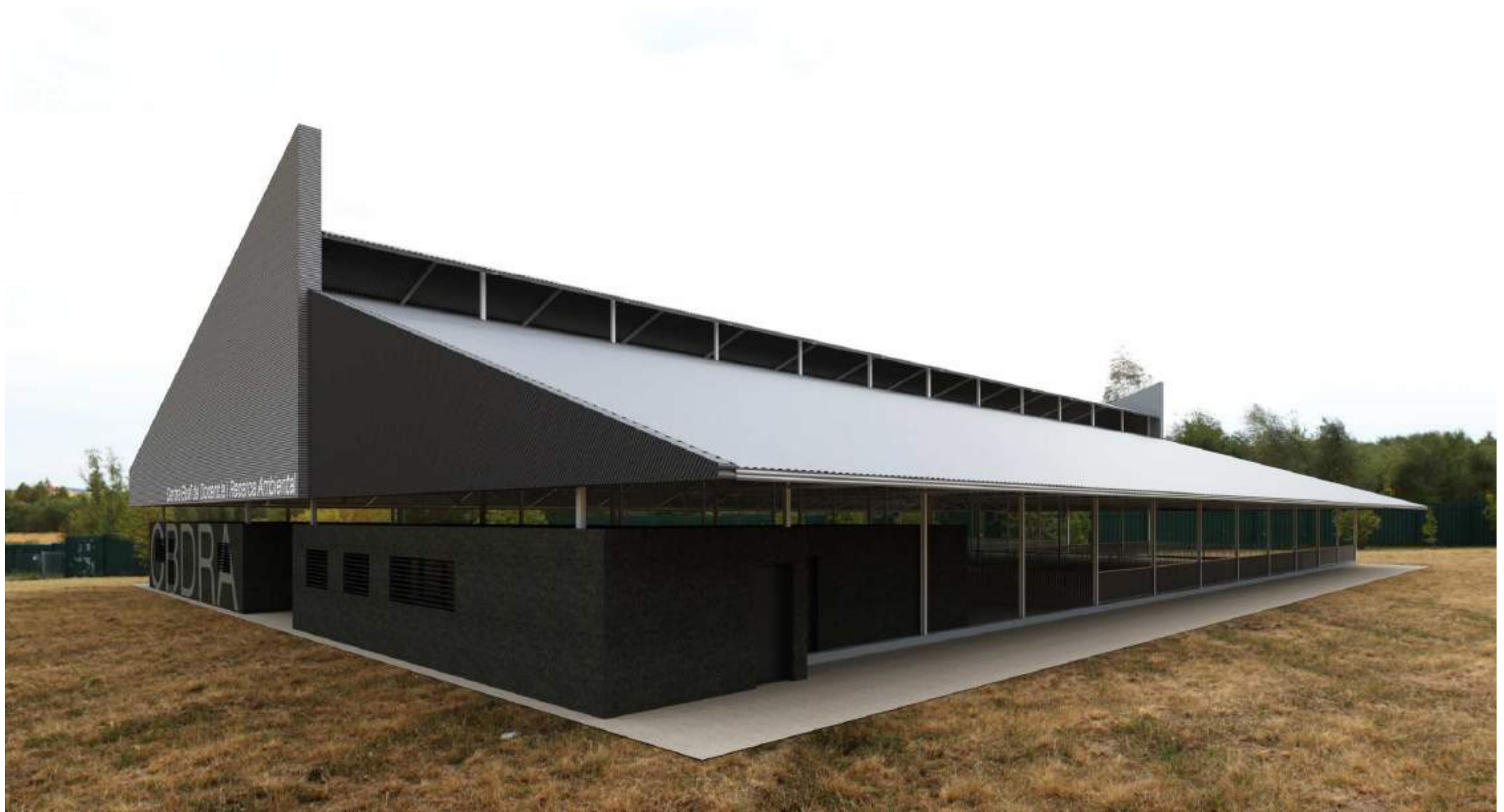
Vista façana Nord-Est.
