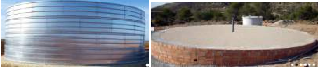
Figura 7.5. Xapa de recobriment del digestor i peu de formigó.
