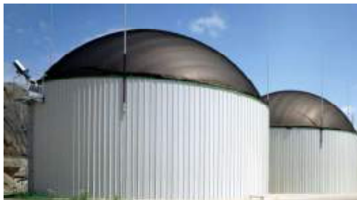
Figura 9.2. Membrana de la coberta de EPDM.
