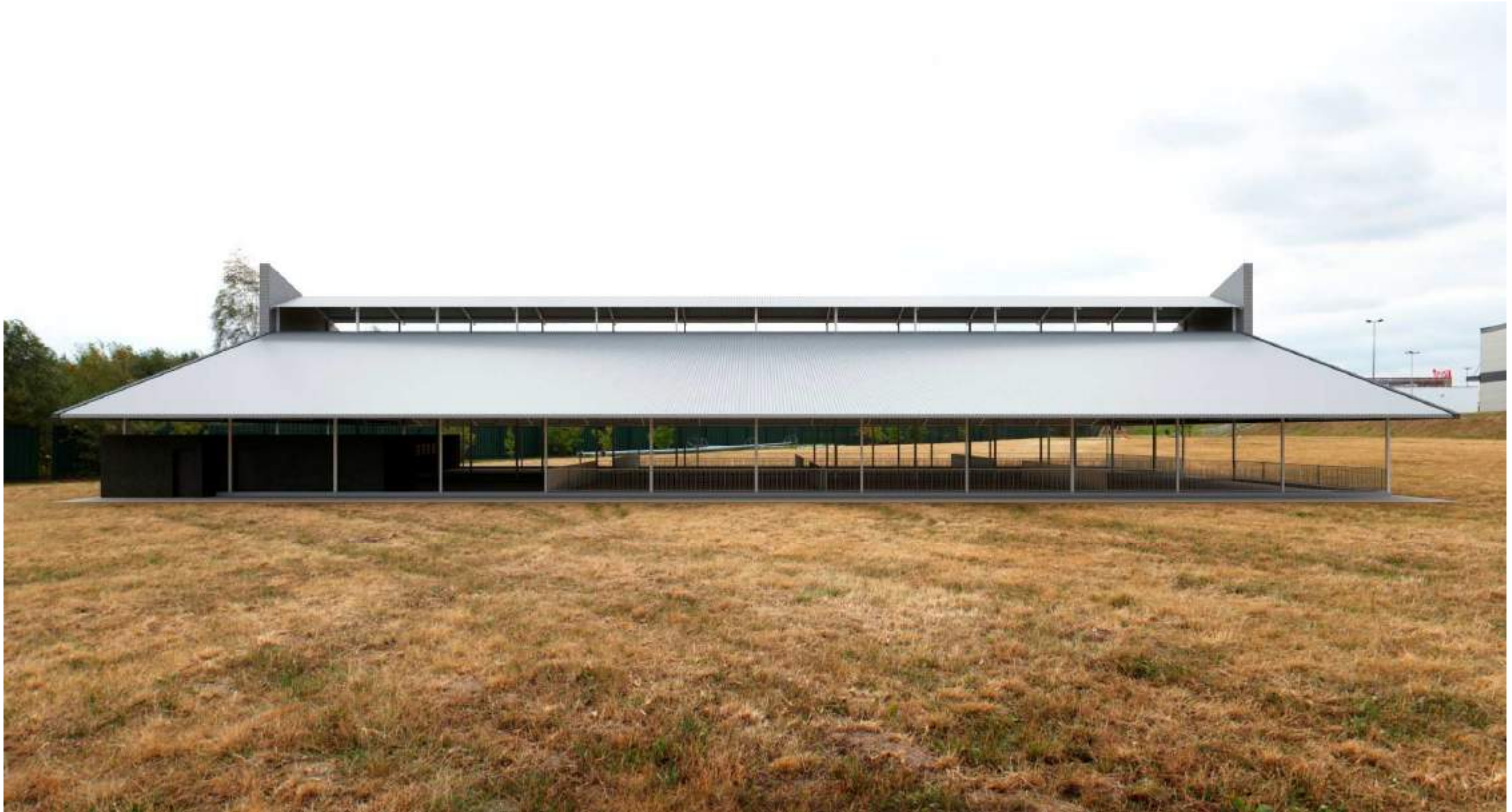
Vista façana Nord.
