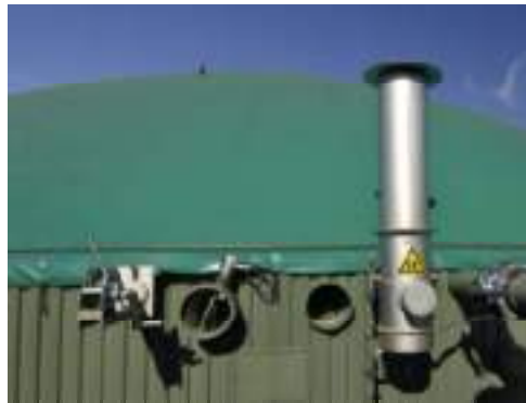
Figura 9.3. Dispositiu de protecció contra la sobrepressió en un digestor.
