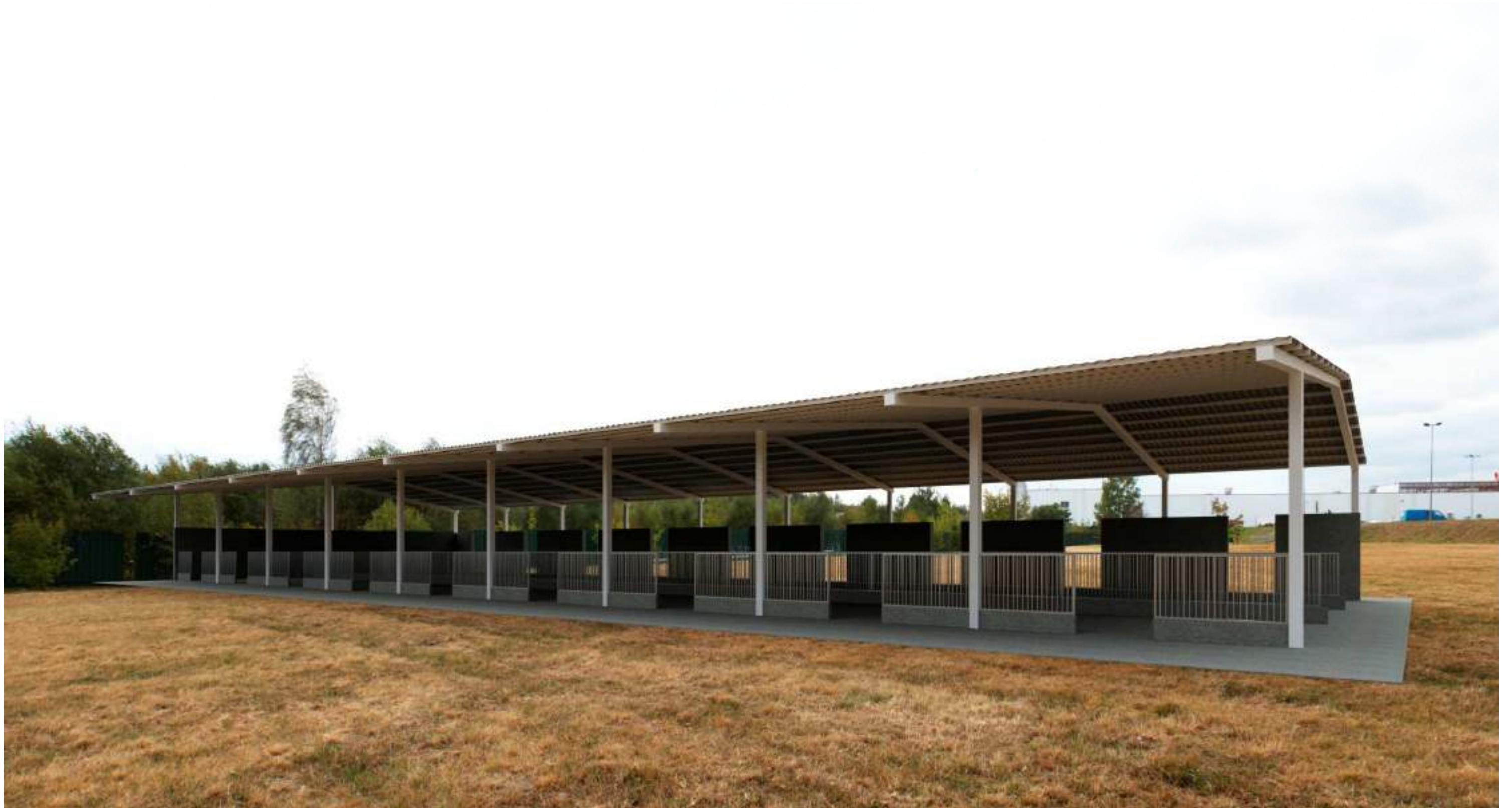
Vista façana Sud-Est.
